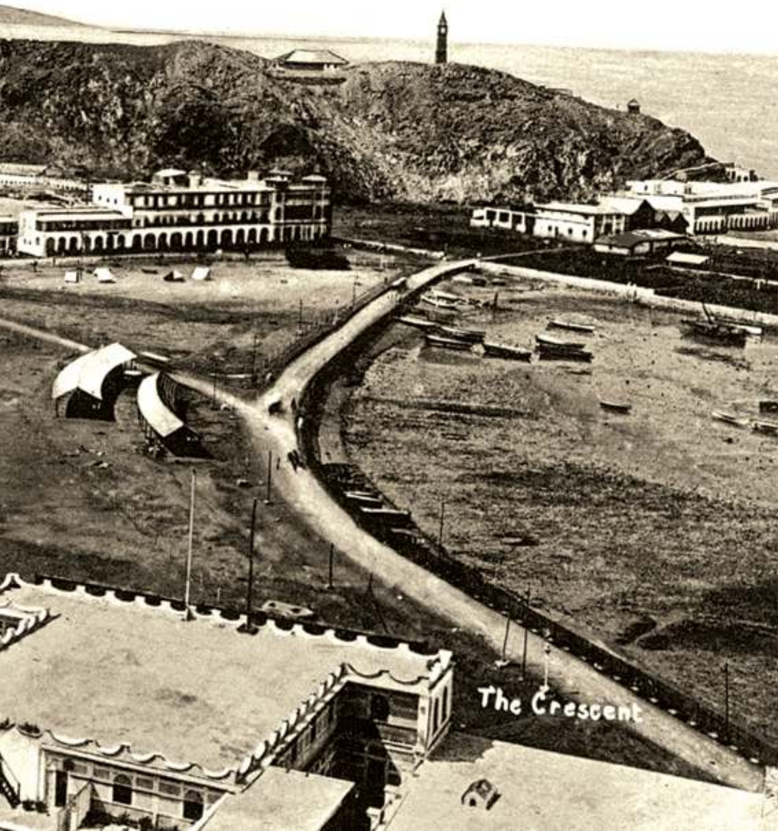
منظر لحي التواهي في عدن وتظهر في قمة الجبل ساعة التواهي التي أطلق عليها اسم "بيج بن الصغرى". وكما تبين الصورة الملعب الرياضي وفندق الهلال الذي كان يملكه توني بس ومبنى شركة قهوجي دنشو وعمارة البنك الأهلي، وتلاحظ مكاتب شركات بول رايس وسرفيس Paul Ries & Sarvies
